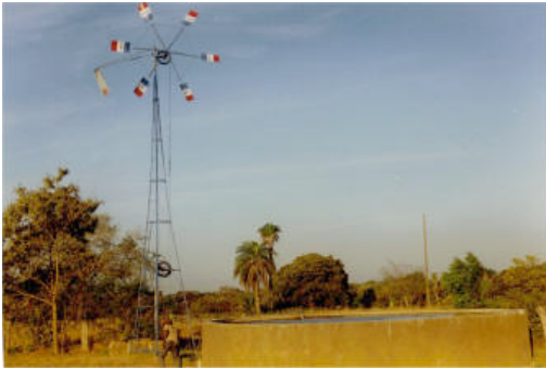
Figura 40: Bombeo de mecate.
