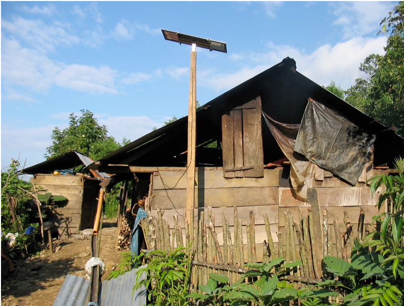
Figura 27: Energía solar para la iluminación de viviendas en el área rural.
